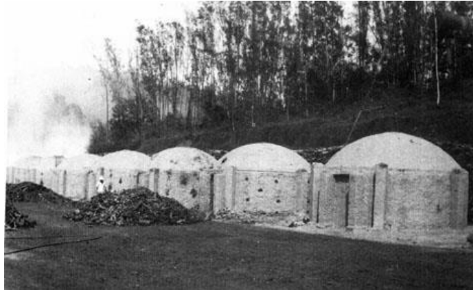
Batería de hornos de ladrillos en varias fases del ciclo de carbonización.
